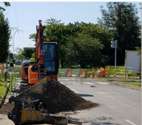
Travaux rue des 44 Arpents (face à Castorama)
