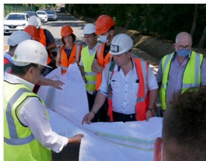
Réunions de chantier régulières pour l'ouverture prochaine du 3 ème pont
