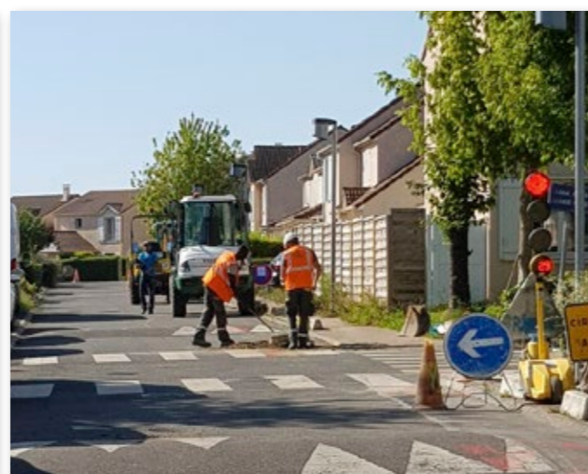
Entretien de la voirie Rue Eridan
