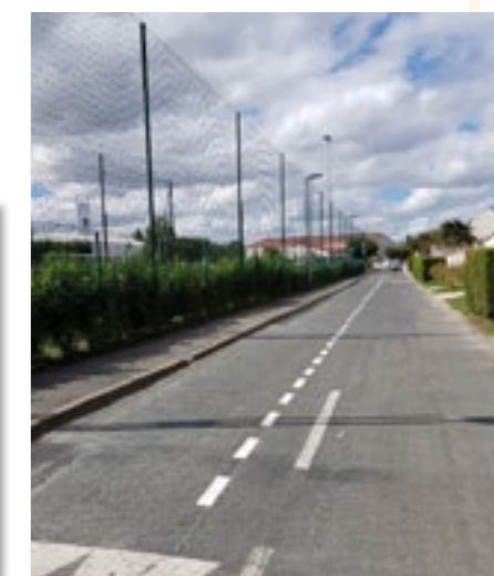
Réalisation de marquage pour le stationnement, rue du chemin vert
