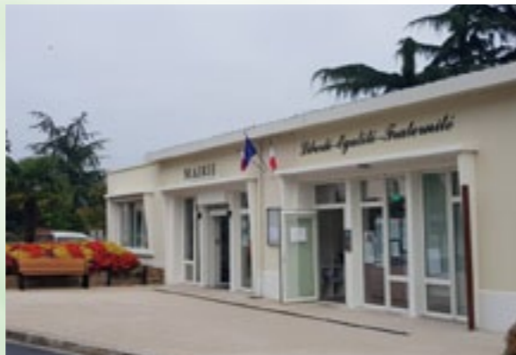
29 juillet : nouvelle façade de la mairie
