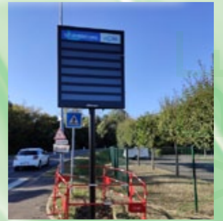
3 sept. : installation de 2 journaux électroniques
