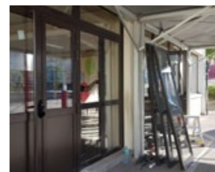
Travaux de rénovation école élémentaire Jean-Jaurès
