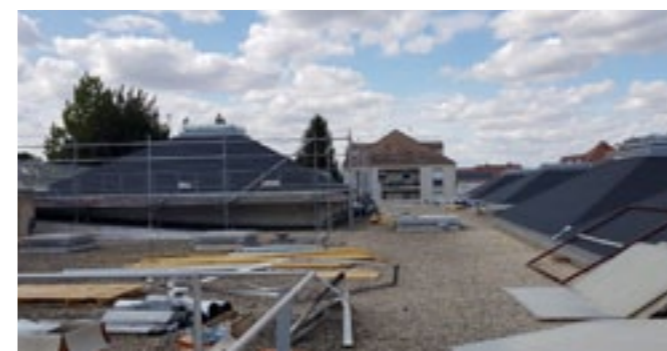
Rénovation de la toiture du groupe scolaire Ariane
