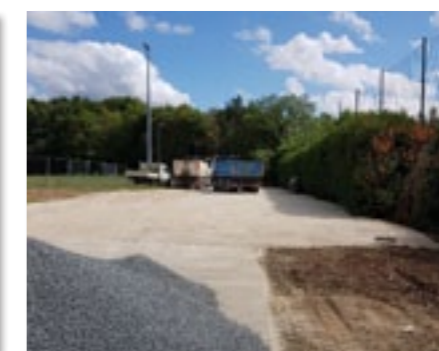
Réalisation d'un parking au niveau des terrains de tennis couverts
