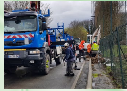
Changement des poteaux rue du Stade
