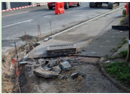
Travaux rue Jean-Jaurès
