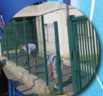
P. 4/5 Travaux été 2016
