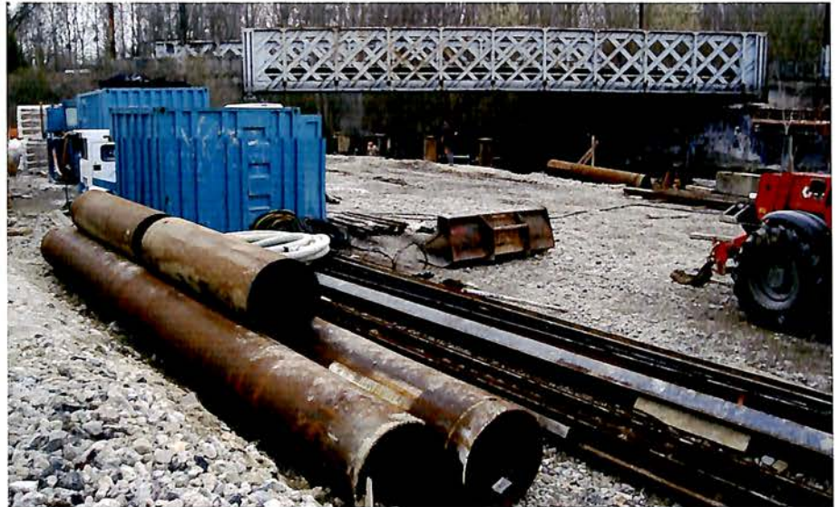
Travaux SNCF - Pont Rail de l'Essonne
