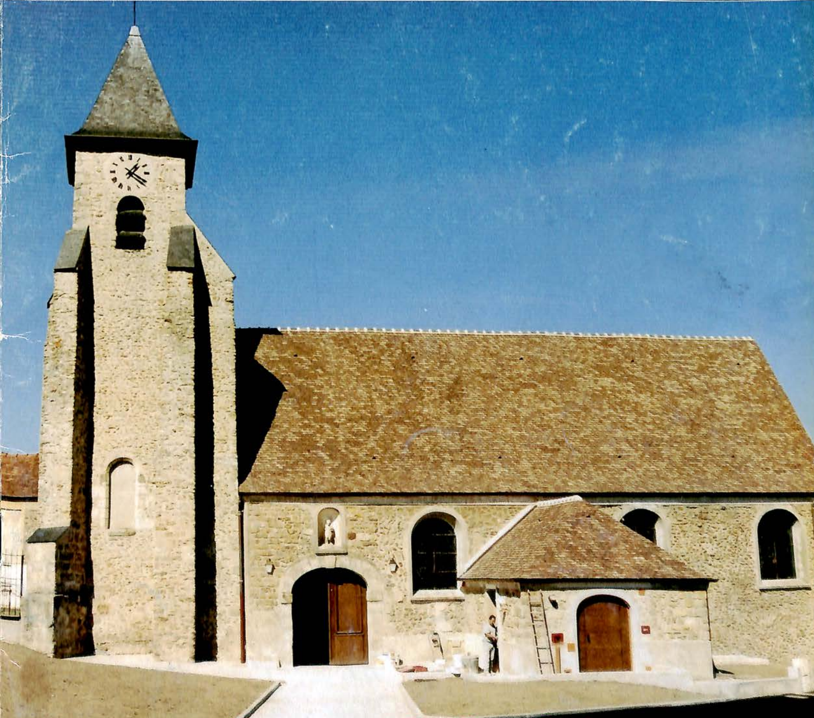
Restauration de l'église Saint Marcel
