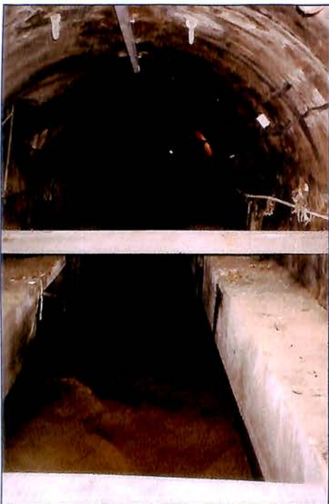
Visite des égouts de Paris. En 1370, le Prévôt de Paris décida de faire construire le premier égout. Avant, les eaux étaient évacuées par des fossés de part et d'autres des rues pavées.
