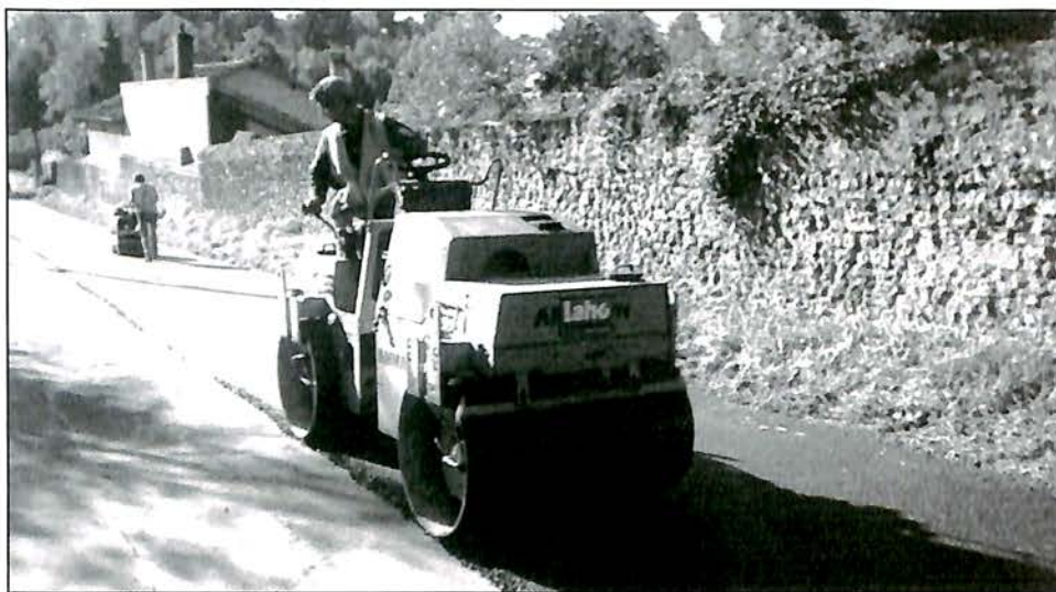
Réfection côte d'Ormoy
