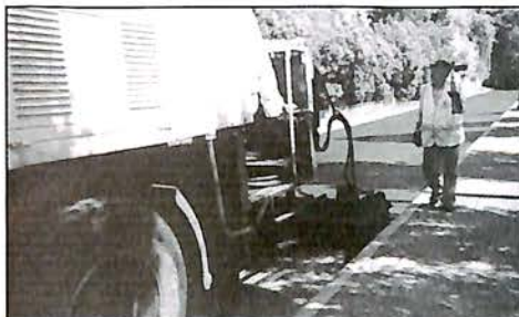
Resurfaçage de la rue du Stade.
