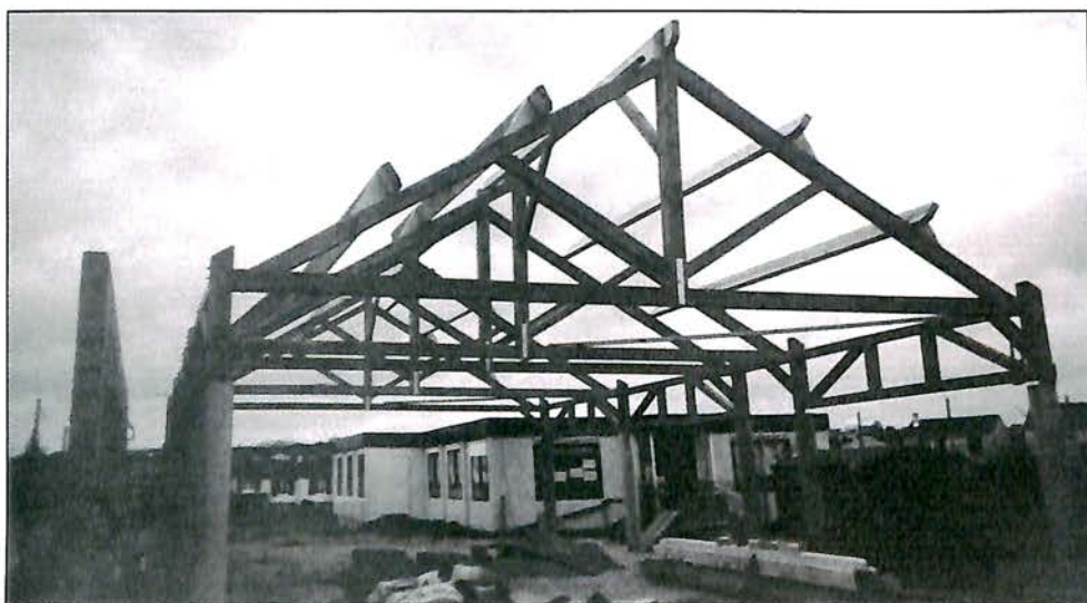
Construction du préau de l'école Ariane
