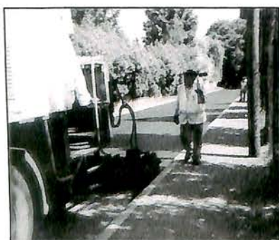
Resurfaçage de la rue du stade
