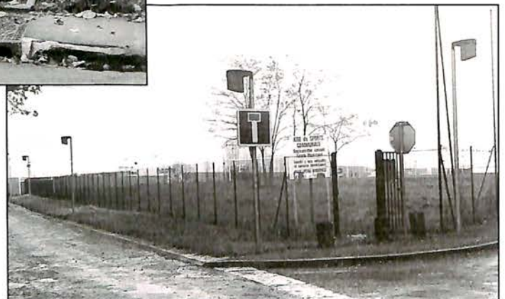
Réalisation de la clôture du stade de football en herbe
