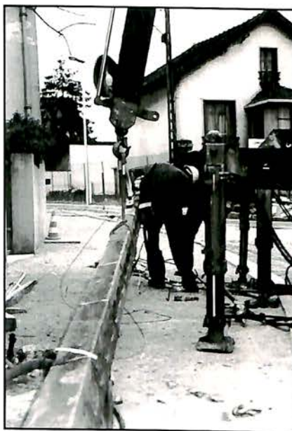
Rue des Prés, enfouissement des réseaux.
