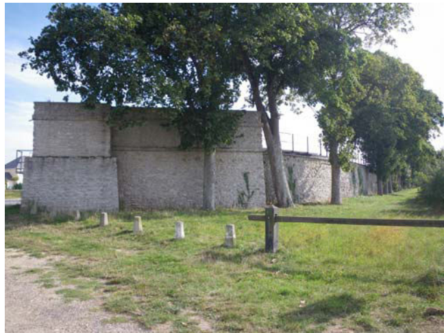
Siphon de la D 153 [AQ-27]
