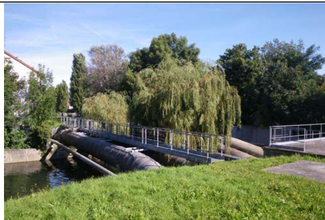
Pont-aqueduc sur l'Orge, avenue du Bellay [AQ-75]
