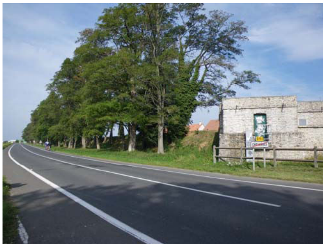
Siphon de la D 153 [AQ-28]
