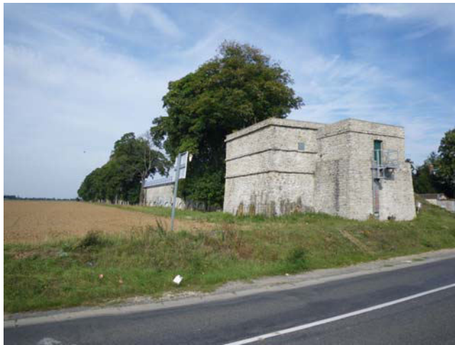
Siphon de la D 74 [AQ-26]
