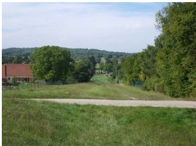
Siphon de l'Ecole, versant est [AQ-07]
