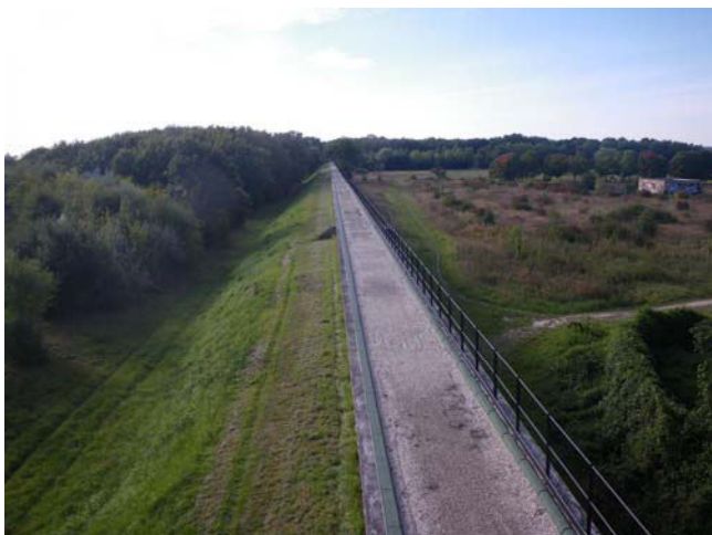
Arcades au nord de la N 104 [AQ-58 &amp; 58b]
