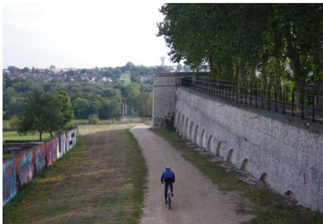
Siphon de l'Essonne, route de Villoison [AQ-45]
