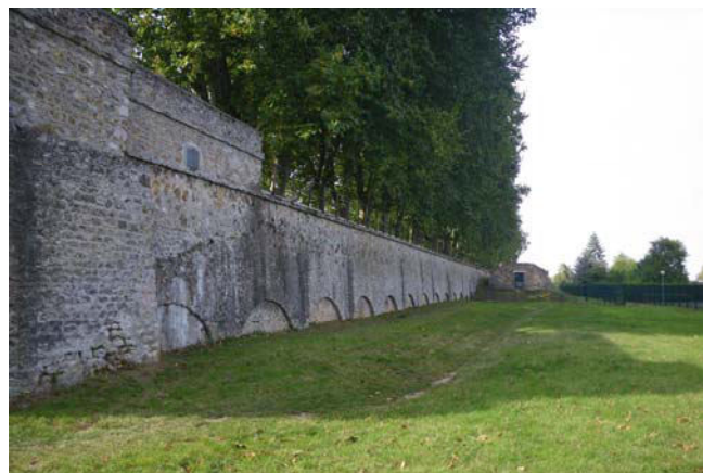
Siphon de l'avenue de la Jeannotte [AQ-37]
