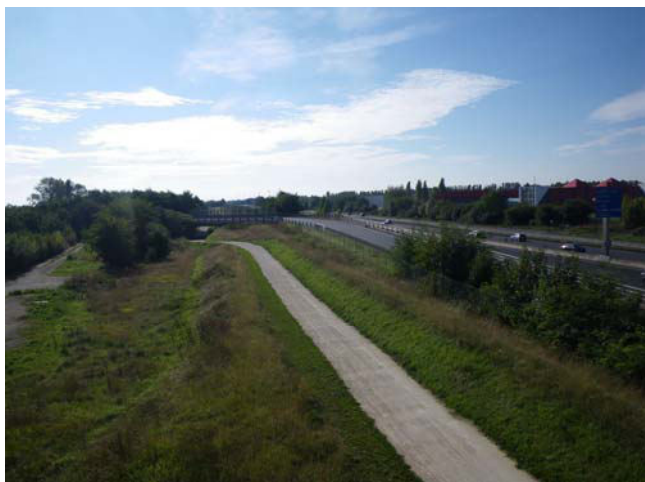
Voie verte parallèle à l'autoroute A6 [AQ-64]
