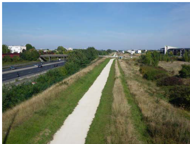
Voie verte parallèle à l'autoroute A6 [AQ-65]
