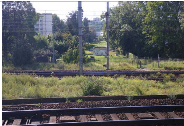
Passage sous la ligne SNCF, av. des Belles Fontaines [AQ-77]
