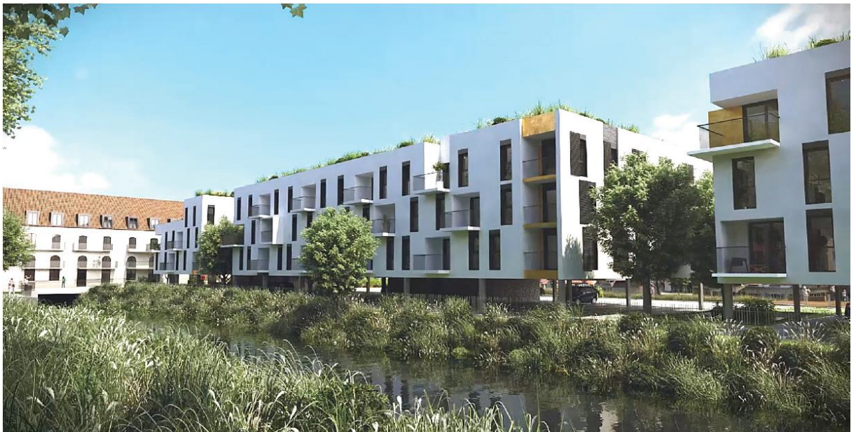
Figure 7: façade ouest des logements familiaux (Source : Requalification de l'île du Moulin Galant/Villabé Valero Gadan Architectes)
