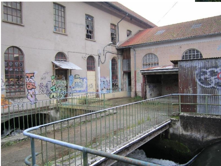
Figure 4: Photos des berges et de l'ancienne usine
