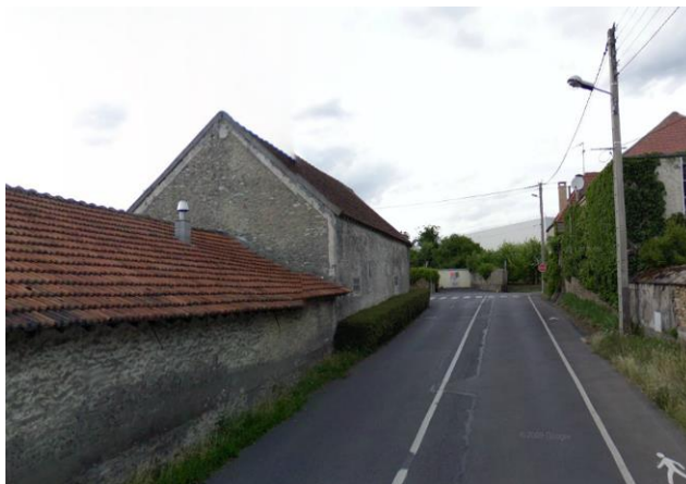
Route d'Ormoy, constructions à l'alignement
