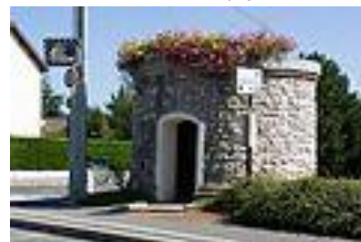
Ancien château d'eau rénové et transformé en abris de voyageur
