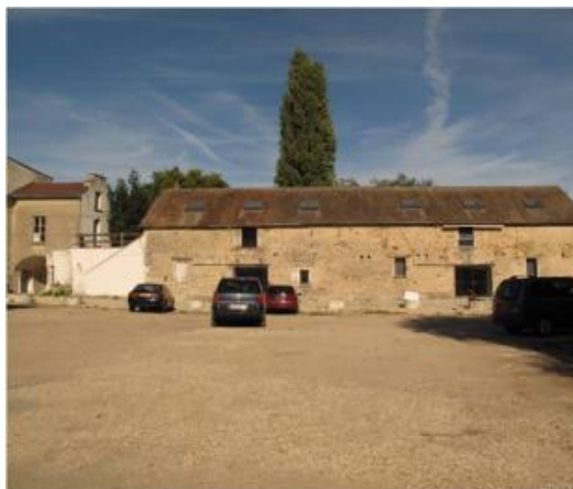
Bâtiments de la ferme de Villoison
